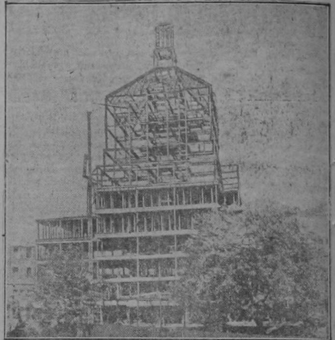
Gigantesca armadura lograda gracias a la soldadura por arco voltaico, en West Philadelphia, para la General Electric Company.
